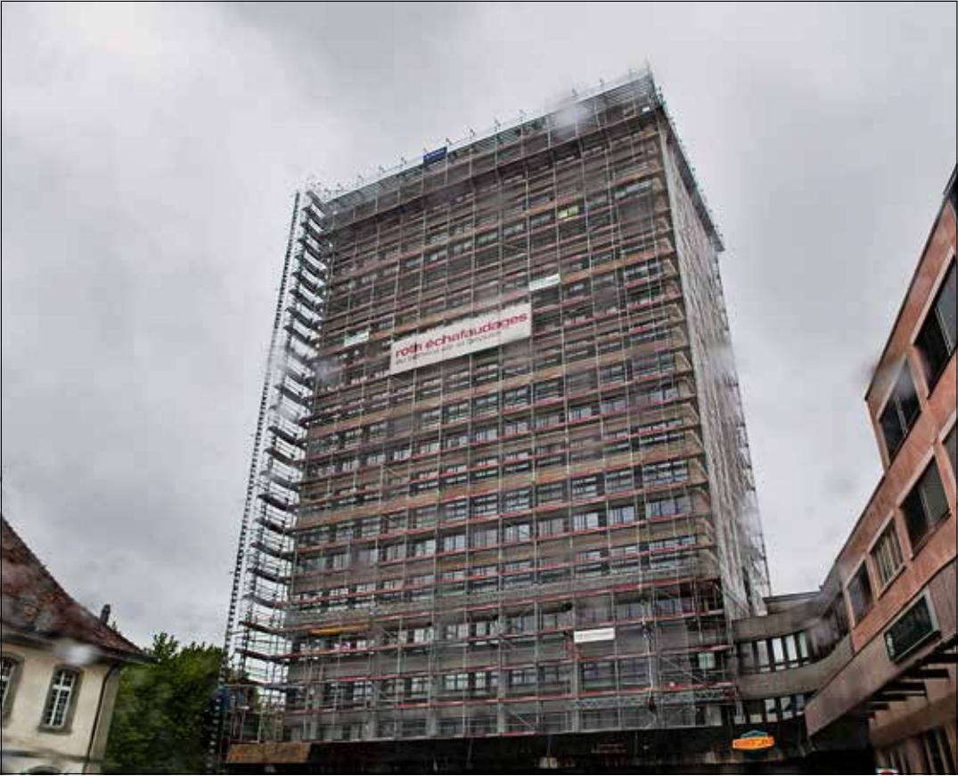
Les travaux de rénovation du NH Hôtel privent les martinets à ventre blanc de leur habitat. CHLOÉ LAMBERT
